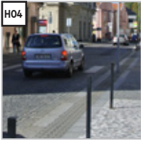
H04 - Atypické řešení rozhraní Např. odtokový žlab / pás jiné dlažby nebo dlažby v jiném směru. Vhodné pro: pěší a obytné zóny.
