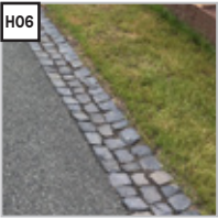
H06 - Řešení bez obruby V případě, že vozovka nesousedí s chodníkem, je vozovka od zeleného pásu oddělena pouze průběžným lemem z kamenných kostek. (Lemuje vozovku, i když zde obruba je). Detail možné využít i pro rozhraní dalších povrchů.
