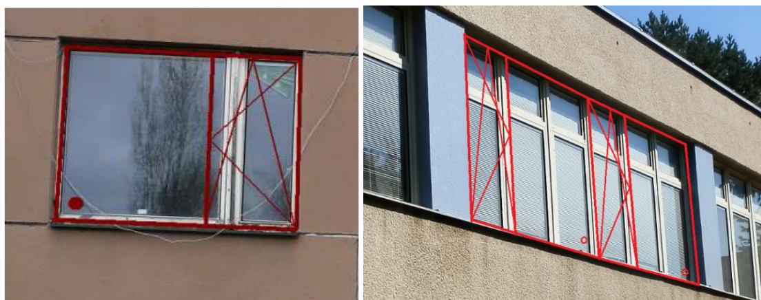
Obrázek 6 Příklad návrhu změny geometrie oken
