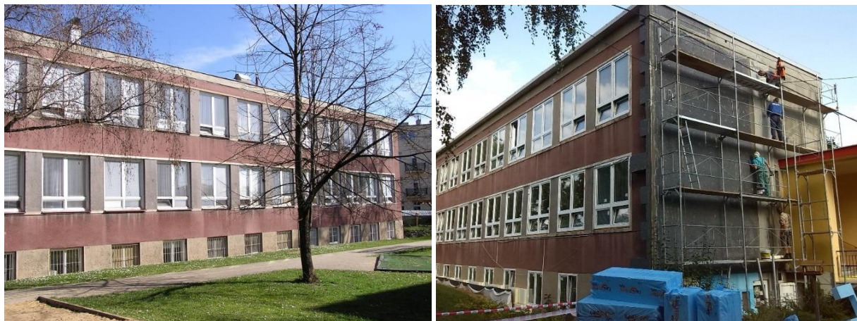
Obrázek 11 Ilustrační foto: původní stav objektu a provádění tepelné izolace
