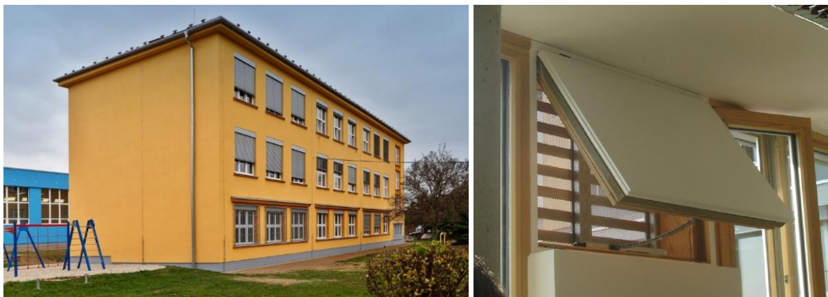
Obrázek 8 Venkovní rolety a klapka nočního provětrání
