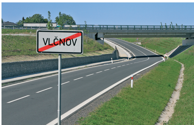
Novostavba chodníku podél přeložené komunikace silnice III/3589, Chrudim-Vlčnov s odvodňovacím žlabem a opěrnou gabionovou stěnou
