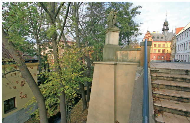
Ze statických důvodů byla v místech pod sousedním Piety provedena sanace opěrné stěny včetně barevné retuše
