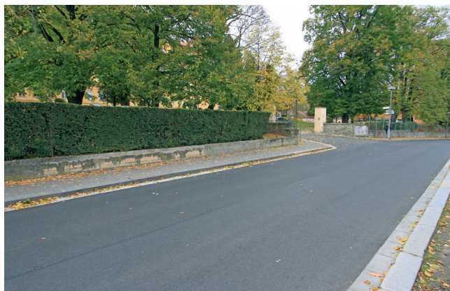
Obnovená obrusná vrstva místní komunikace v Olbrachtově ulici před Gymnaziem Josefa Ressela
