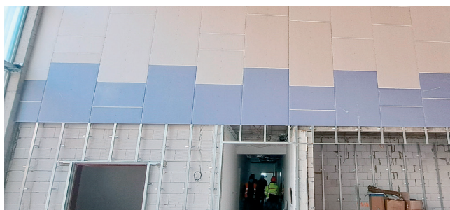
Obklad stěny malé sportovní haly
